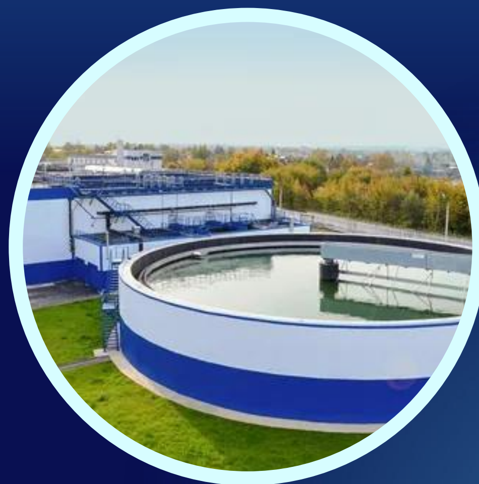
ОЧИСТНЫЕ СООРУЖЕНИЯ И ВОДОКАНАЛЫ
