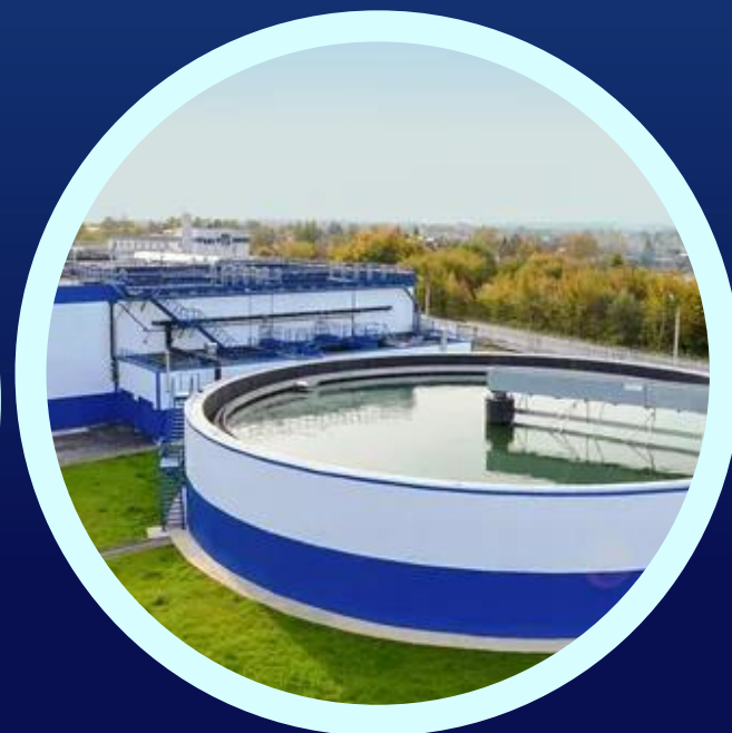
ОЧИСТНЫЕ СООРУЖЕНИЯ и ВОДОКАНАЛЫ
