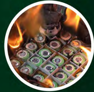
литий-ионные системы накопления энергии
